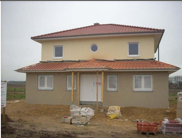
Erstellung der Eingangsüberdachung
