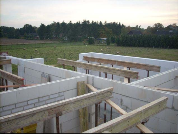
Die Rohbau-Innenwände vor dem Einbau der Erdgeschoss-Decke
