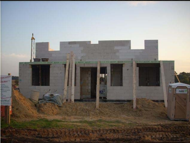
Das Dachgeschoss-Mauerwerk im Rohbau
