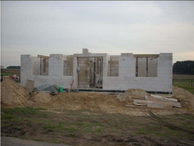
Fertigstellung des Erdgeschoss-Mauerwerks
