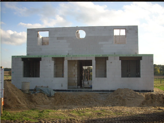
Fertigstellung des Rohbaus kurz vor dem Richten des Dachstuhls
