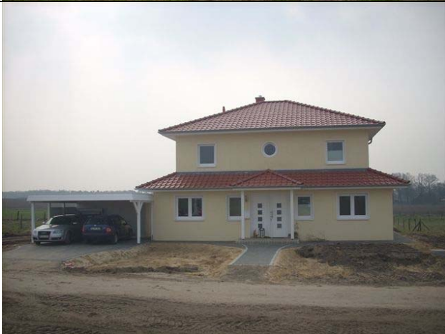
Fertigstellung der Außenfassade
