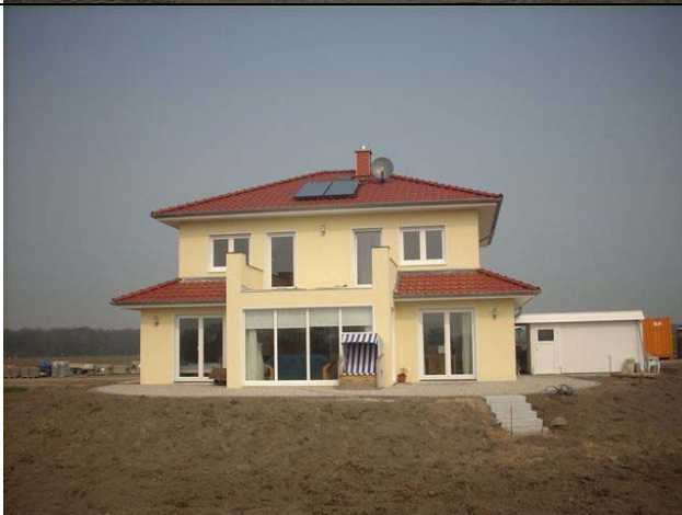
Mutterbodenauffüllung und Beginn mit der Erstellung der Außenanlage
