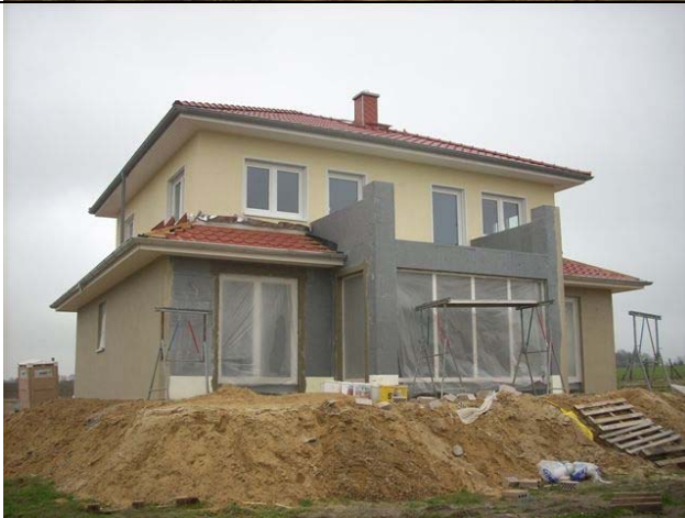
Putzarbeiten Erdgeschoss und Loggia
